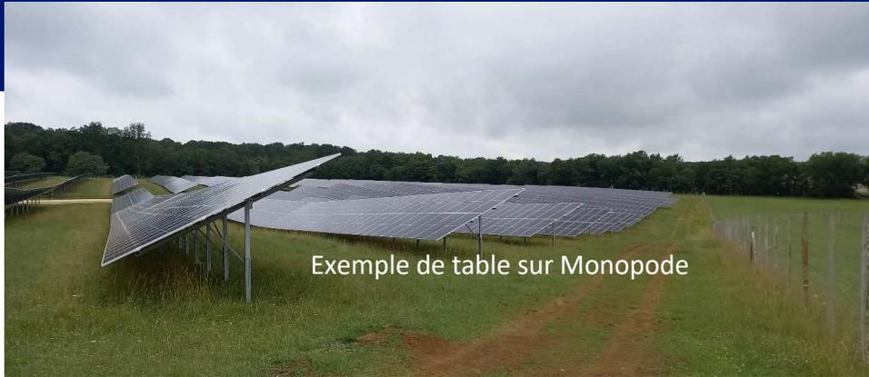
Table = structure métallique supportant les panneaux (appelés également modules)
